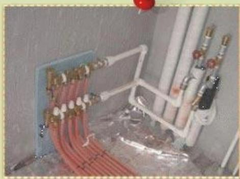
地热怎么安装二、地热分集水器固定安装连接。
