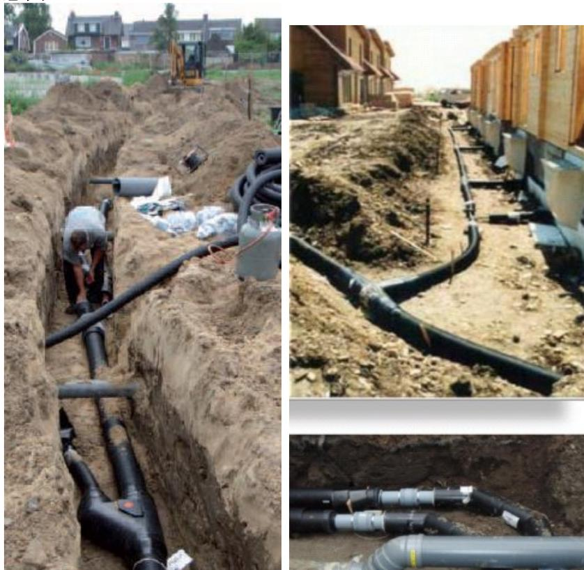
上图是热力管网居民小区内入户管路铺设的施工图，由图中可见塑料管材可以在施工中有有一定的弯曲度，分支和连接更加方便易操作。
